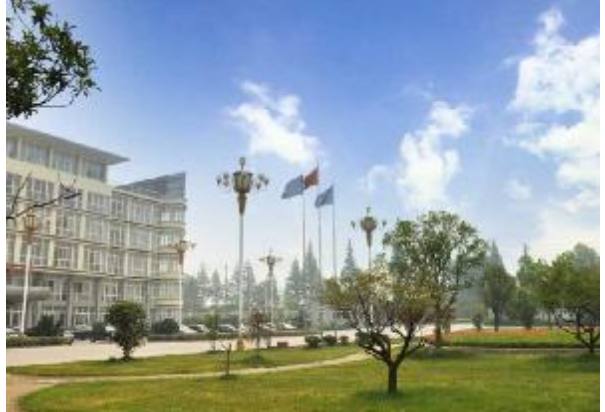
公司办公大楼
