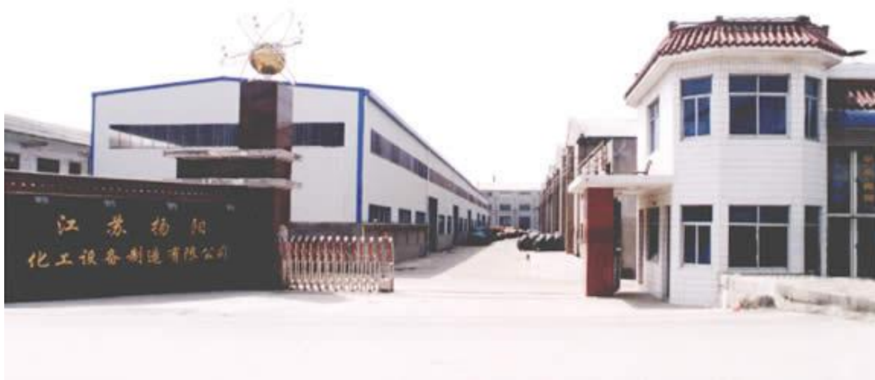
江苏扬阳老厂区
